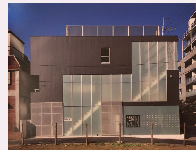
[70] 5 Floors (1998), Toshiaki Ishida. Área do lote: 85,4m 2
