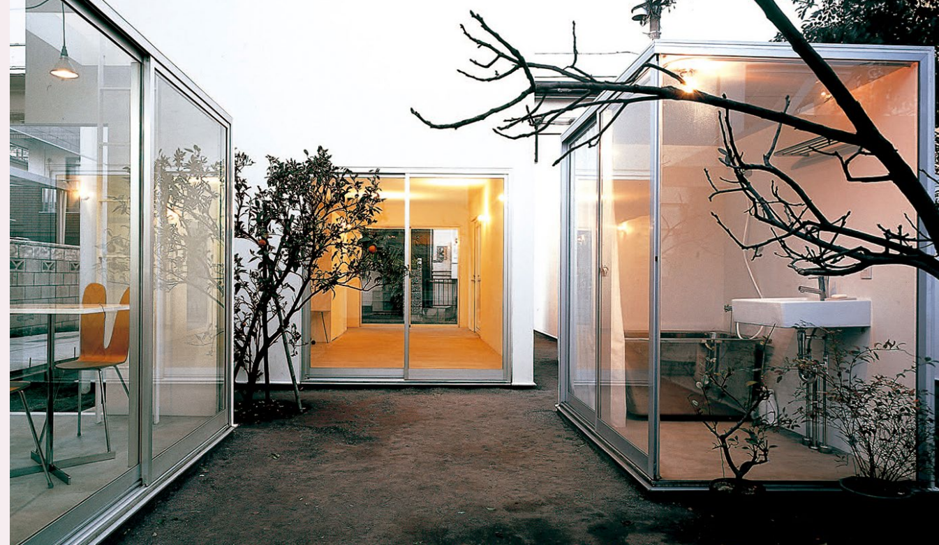
[141] Bloco B a esquerda. Bloco A ao centro. Bloco D a direita.
