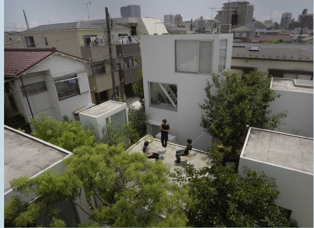
BLOCO G cobertura
