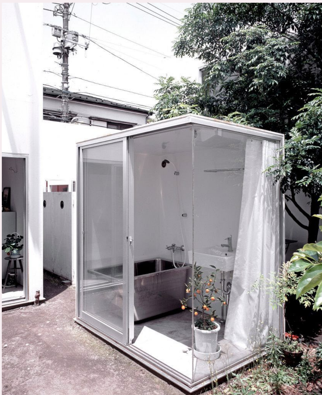
[143] Banheiro (Bloco D), isolado no lote e acessível pelo jardim. Com dimensões apenas para uma pessoa (1,25 x 1,81m), possui apenas uma pia e banheira com chuveiro. A privacidade do usuário é garantida pelo posicionamento no centro do lote e pelas cortinas.
